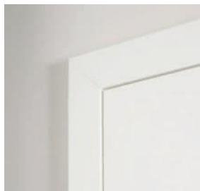
Omlijstingen in verstek, deur en omlijsting in hetzelfde vlak — Chambranles en onglet, la porte et les chambranles à fleur
