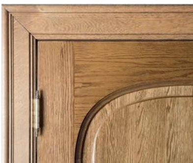
Omlijsting 7: creus luxe 22 x 90, eik massief — Chambranle 7: creus luxe 22 x 90, chêne massif
